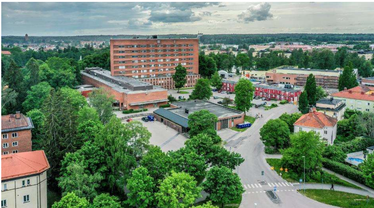
Drönarvy över Sala lasarett sett från. Högdelen i fonden, lågdelen nedanför och närmast Lasarettsgatan ligger hus 5 (Foto: Karl Gabor, juni 2021)
