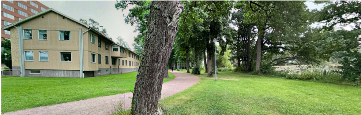
Passage närmast Ekeby dammar. Till vänster det gamla sjukhemmet (hus 8).
